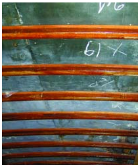
Die alte Salondecke
